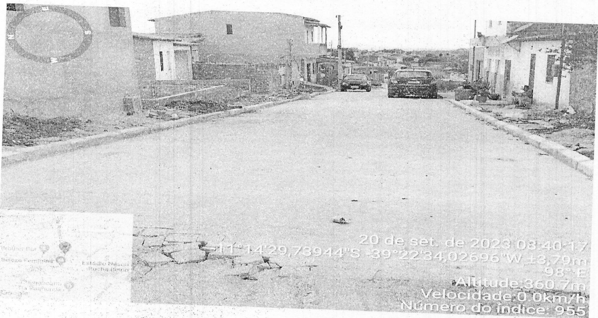
Execução de Pavimentação da Rua projetada 05 (trecho III)
