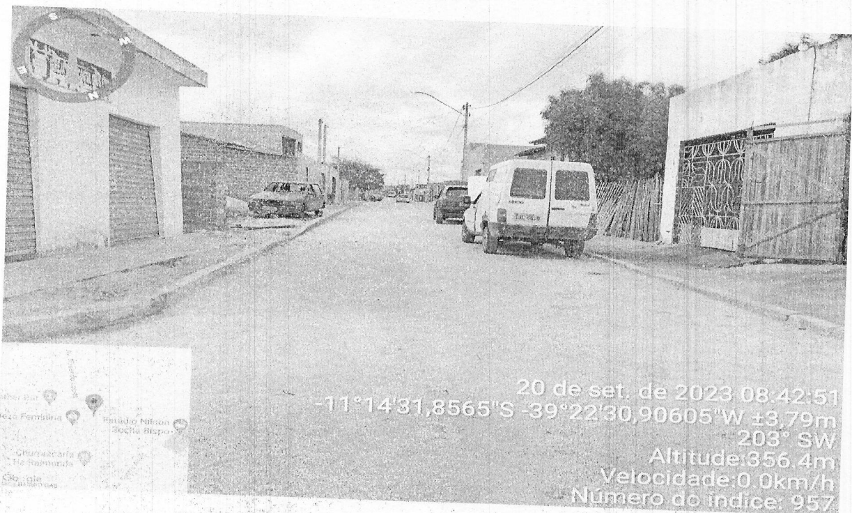
Execução de Pavimentação da Rua Izidro José dos Santos (trecho I)
