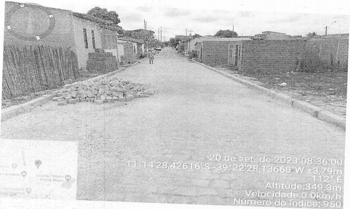
Execução de Pavimentação da Rua projetada 04
