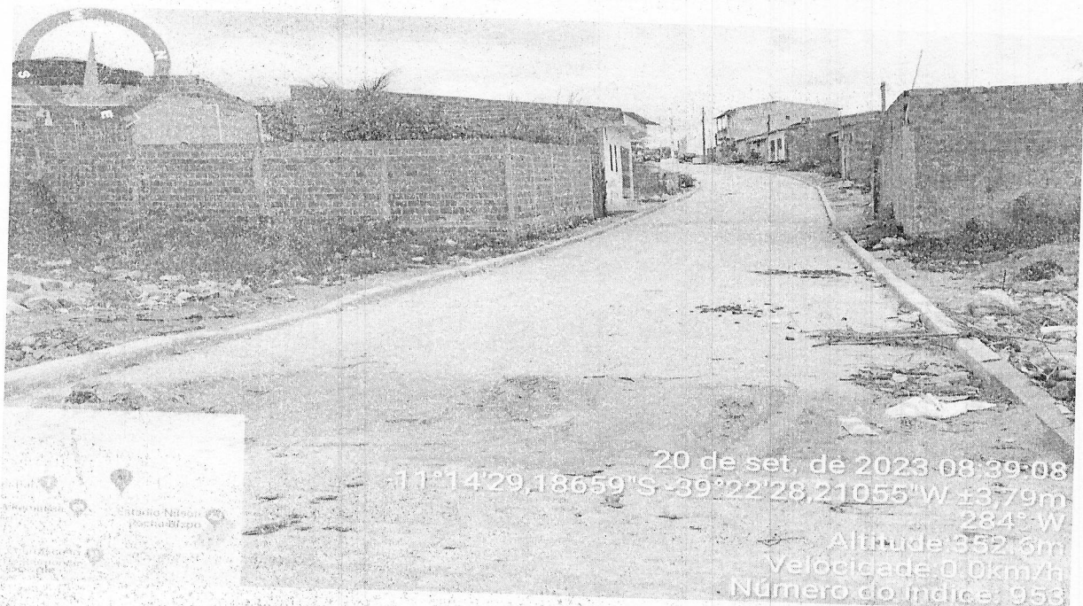
Execução de Pavimentação da Rua projetada 05 (trecho I)
