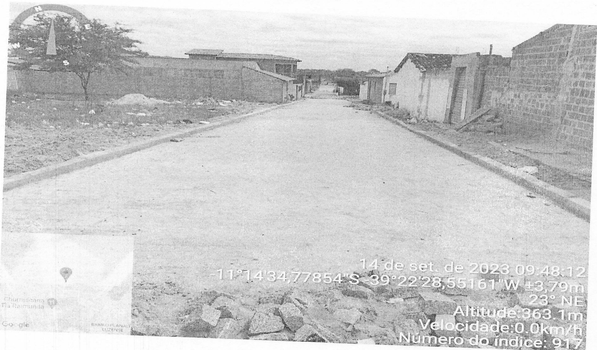
Execução de Pavimentação da Rua projetada 10
